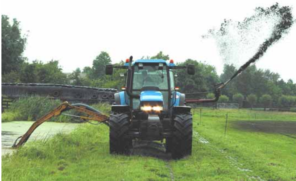
Foto: sloot C1 wordt gebaggerd met behulp van de baggerpomp.
