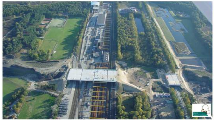
Natuurbrug Zanderij Crailoo in aanbouw
